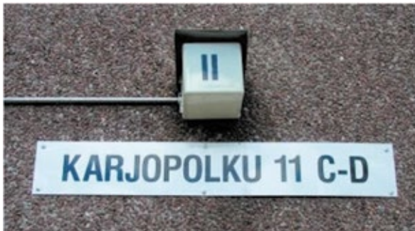
Kuva 4. Rakennuksen osoitemerkitä kadunnimi ja -numero -mallin mukaisesti (niminumerokilpi).
